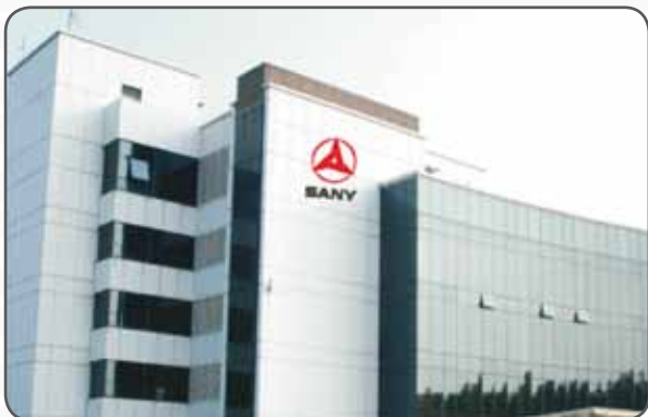
Parque Industrial de Beijing
